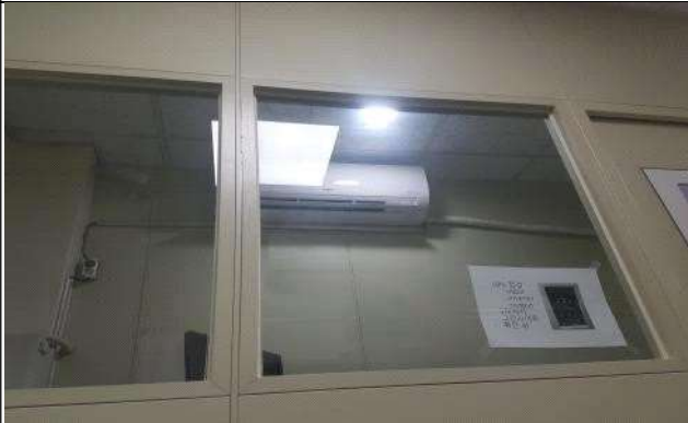
3. 기계관 2층 216호 서버실 화재감지기 설치
