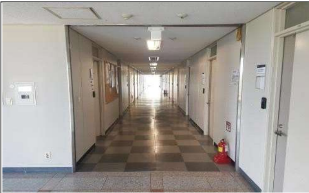
5. 본관 5층 510호 옆 방화셔터 526호 방향 레인 이탈 보수
