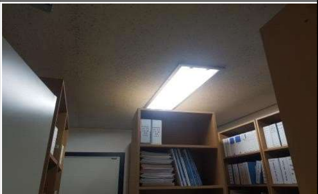
4. 학생회관 2층 수신기실 화재감지기 설치
