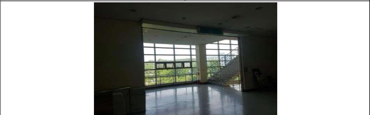
9. 우주센타 2층 중앙계단 방화셔터 폐쇄기 복구
