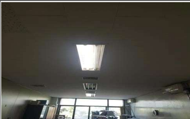
1. 과학관 3층 302-2호 화재감지기 설치
