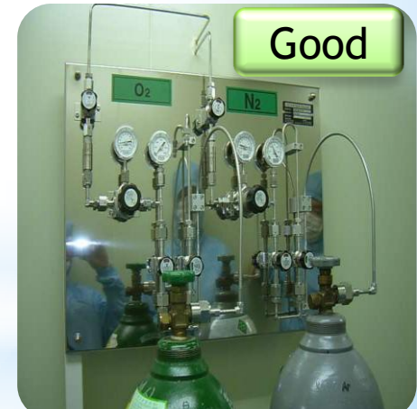
배관 고정 설치 및 Label 부착 미 사용배관 마감장치 설치 등
