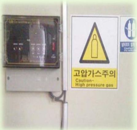
가스누출 경보기 설치
