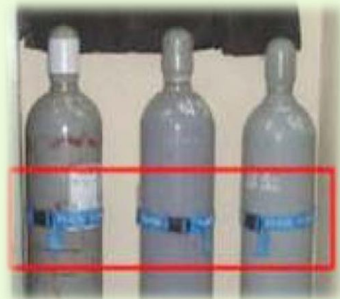
전도 방지 장치 설치
