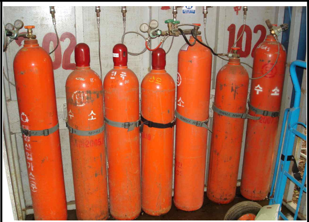
수소 저장소 설치(활성가스 옥외 저장소 설치)
