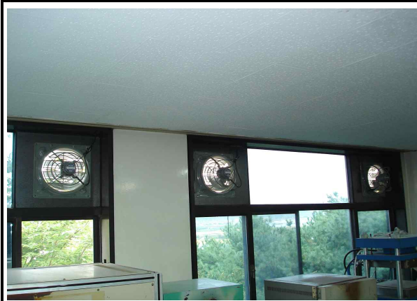
환기 시설 설치
