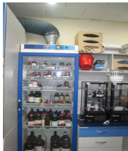
올바른 예. 배기구가 설치된 시약보관함
