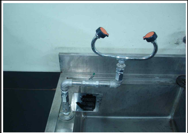
비상 세안장치 설치
