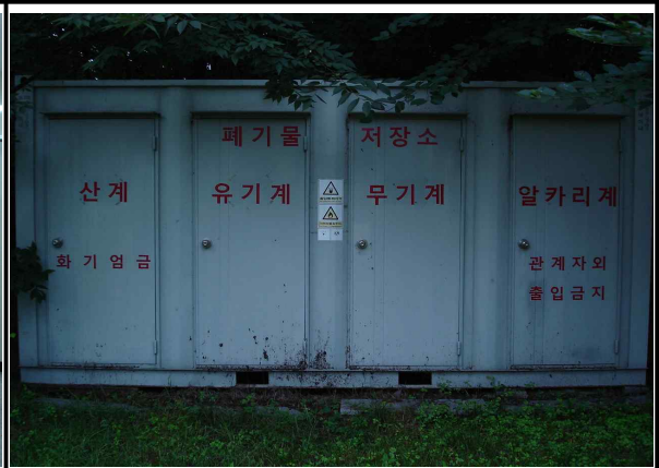
폐기물 저장소 설치
