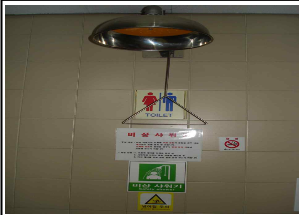
비상 샤워장치 설치
