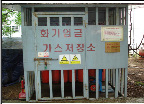
수소 저장소 설치(활성가스 옥외 저장소 설치)
